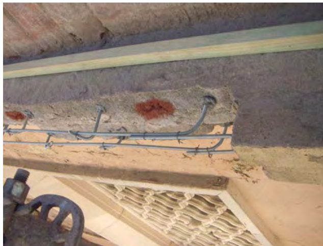
REPOSICION DE ELEMENTOS
