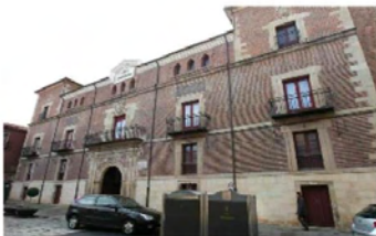
7_ NUEVO RECREO INDUSTRIAL
